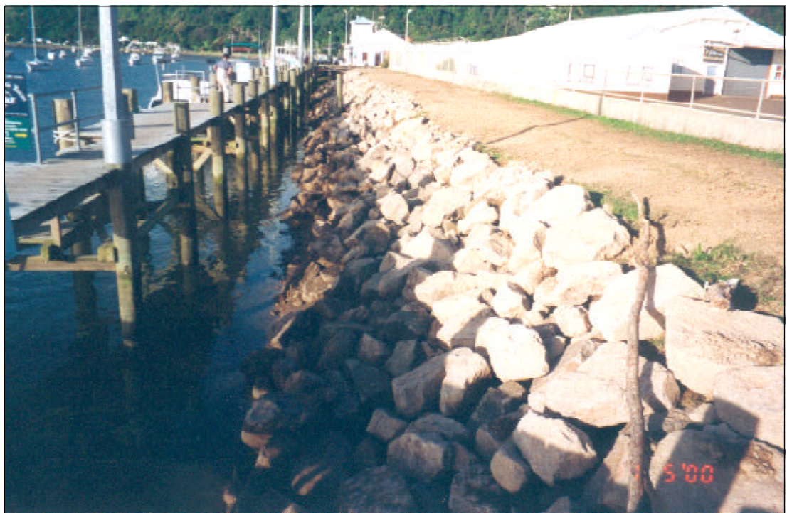
Figure 17 Rock riprap edge protection works
